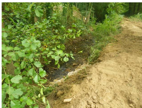
REPRISE DE LA BERGE DU MAZANAN
