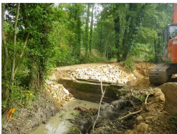
REPRISE DU DEVERSOIR ET DE LA DIGUE
