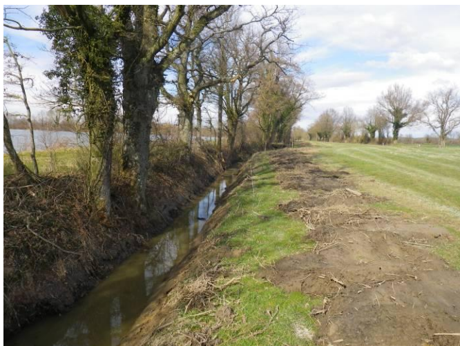
TRAVAUX SUR LA COMMUNE DE SANDRANS
