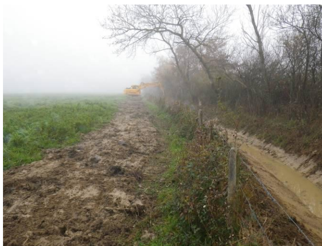
TRAVAUX SUR LA COMMUNE DE VILLARS LES DOMBES
