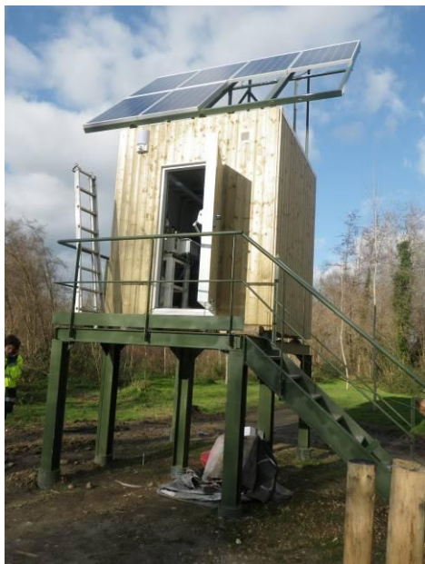
LOCAL TECHNIQUE INSTALLEE HORS D'EAU
