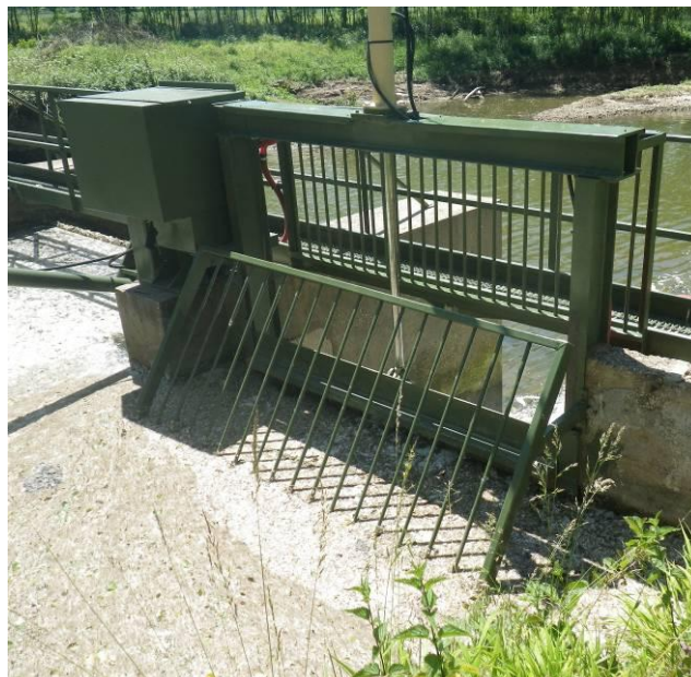
VANNE GUILLOTINE AUTOMATISEE
